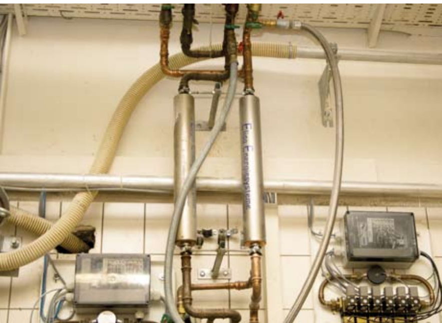
Links sind die an der Rückseite der Teigmacherei angebrachten Module von Elisa zu sehen. Das mit Edelsteinen gefüllte Modul direkt an der Verwiegung dient eher publikumswirksamen Effekten als der Wasserqualität.
